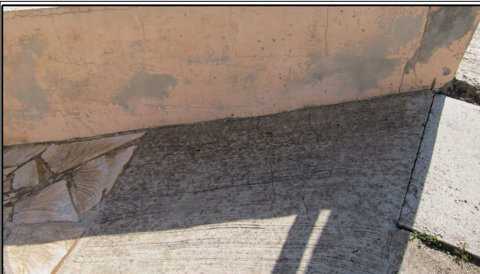
Foto n° 38) Bacino Ponte A - particolare delle crepe al di sopra dello scarico.
